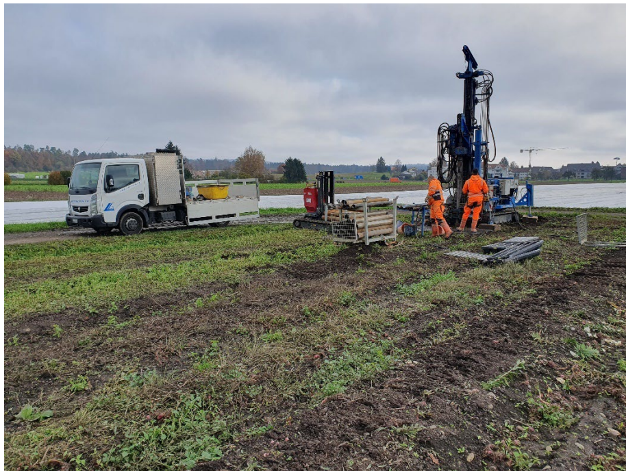
Ansicht Untersuchungsareal während Ausführung Kernbohrung KB 24-2, Blickrichtung ca. Ost
