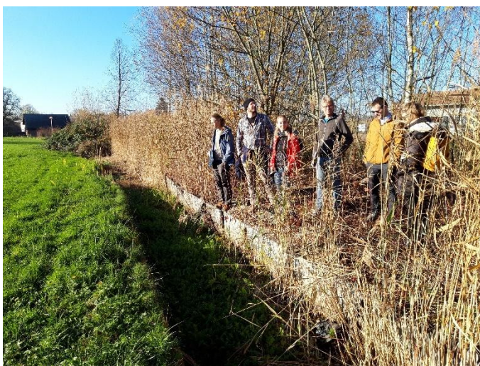
Abbildung 3: Gewässerverbauung entlang Kat.-Nr. E3527. 14. Mai 2020
