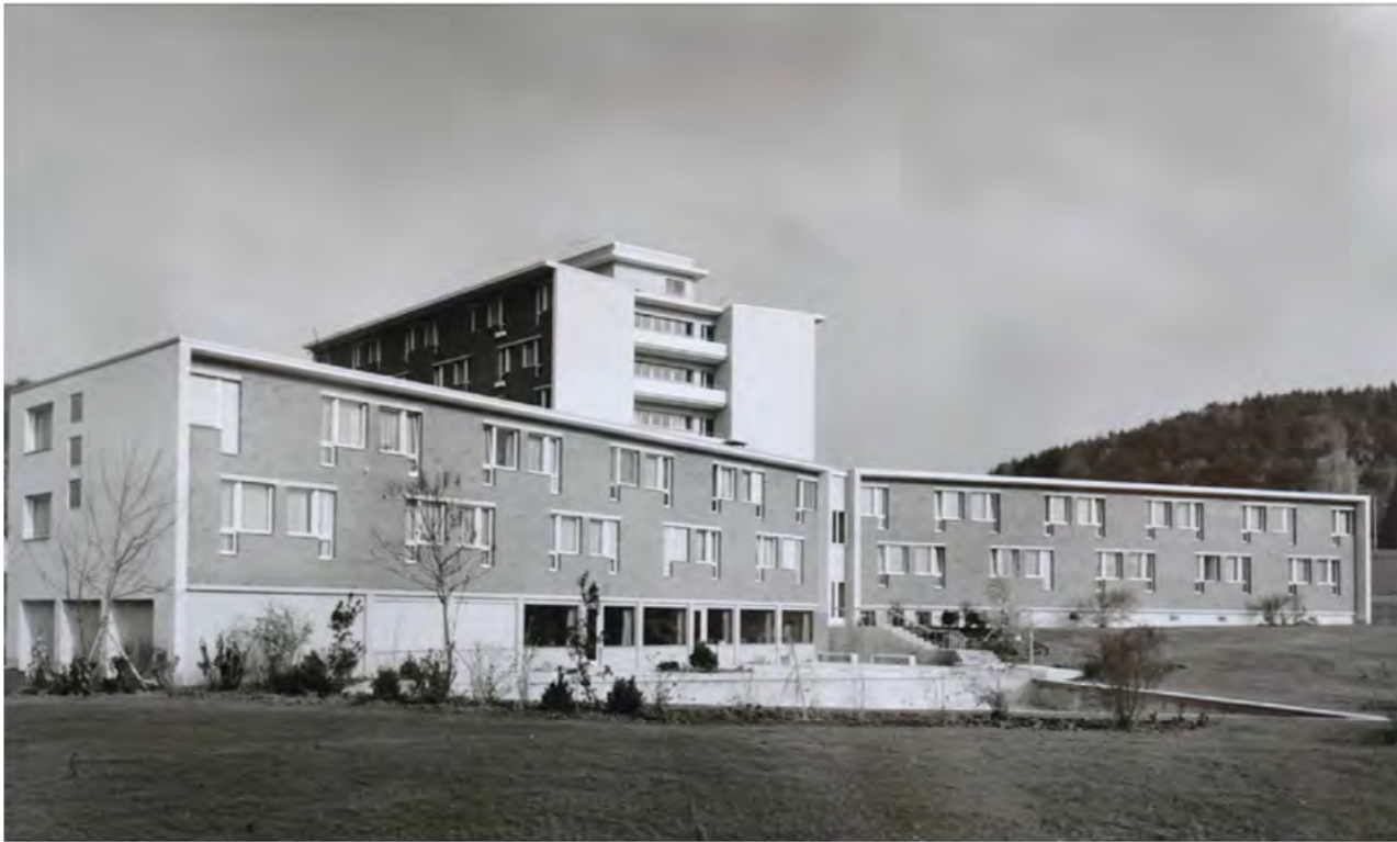
1962 Südfassade, Gutachten S.27, aus Archiv Meier
