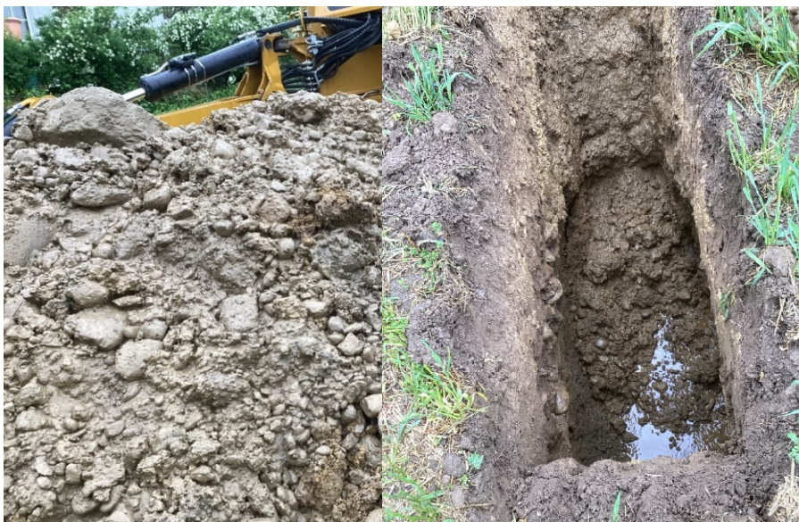
Abbildung 6: Nasser bzw. grundwasserführender Moränenschotter aus BS 25-1/P (linkes Bild) bzw. nicht standfest und rasch einbrechend in BS 25-2/VS (rechtes Bild)
