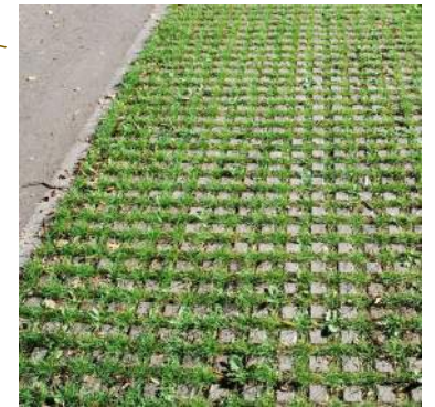
Rasengitterstein Bugnato, Versickerungsleistung ca 1390l/s ha
