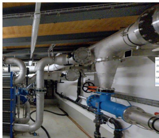
Abbildung 57: Blick in Technikraum Fernwärme. Oben: Blick nach Norden. Die Querleitung ist der Zulauf von SBX. Dahinter sind die Zuleitungen von den Speicherbecken. Unten: Blick Richtung Süden mit den Wänden hinten und rechts für die Leitungsdurchführungen.
