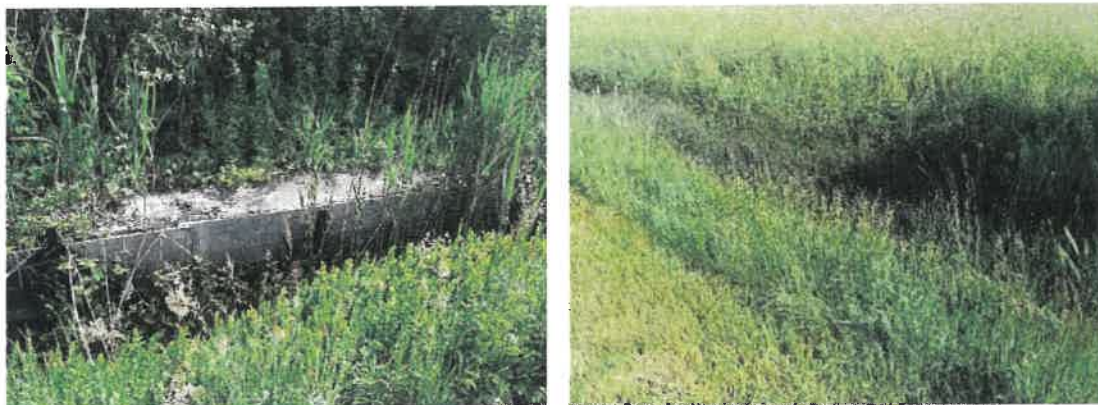
Abbildung 20: Der Nänikerbach im Projektabschnitt. Links: mit „Hobbyverbau“ (Schalttafel und Magerbeton), rechts: fehlende Riedvegetation beidseitig vom Bach, hohe Ufer/eingetiefter Bach.
