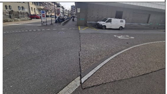
Abbildung 12: Blick auf Fuge Tiefgarage aus Westen
