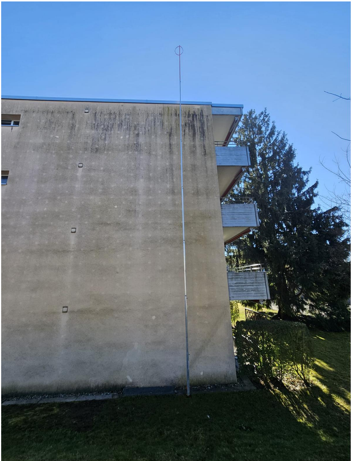
Fotos Aussteckung Kamin
