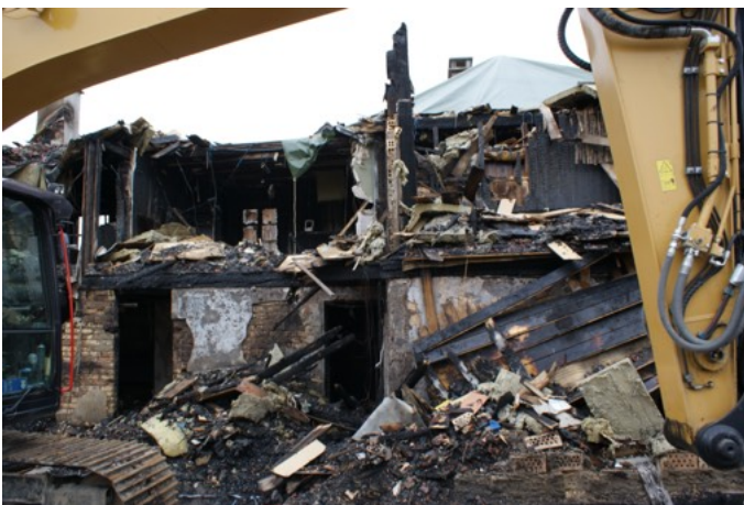
Ansicht von Norden. Die internen Wände zum Gang blieben stehen.
