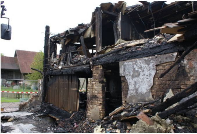
Detail Wohnhaus. Vorne links Wand zu Stube.
