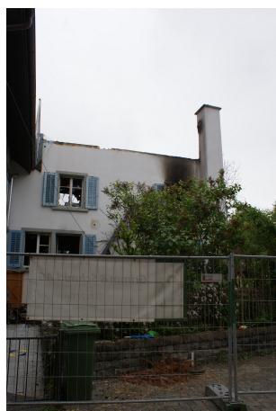
Links: Ostwand Rechts: Südwand
