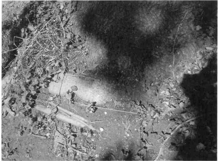
10 Würgewurzeln und Adventivwurzeln können Hinweis für einen alten Wurzelschaden sein.
