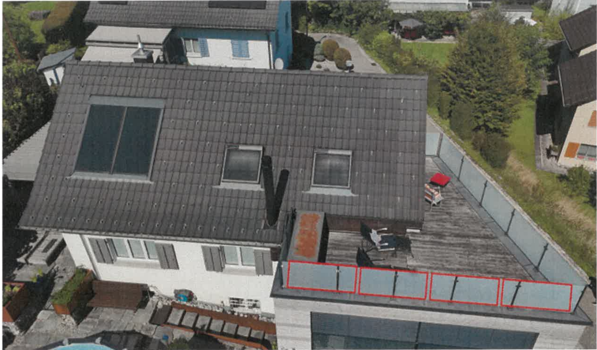
Foto Geländer Südwest
