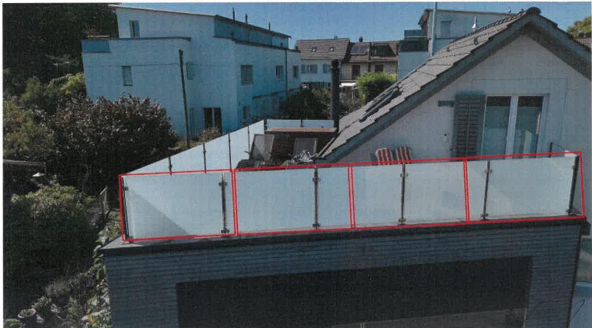
Foto Geländer Südost
