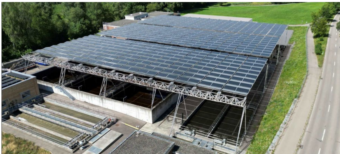
Abbildung: Visualisierung Solarfaltdach (ohne Projekt EMV-Gebäude)
