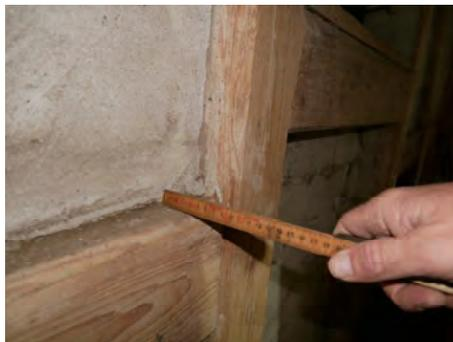
Abb. 6 Ausgemauertes Gefach
