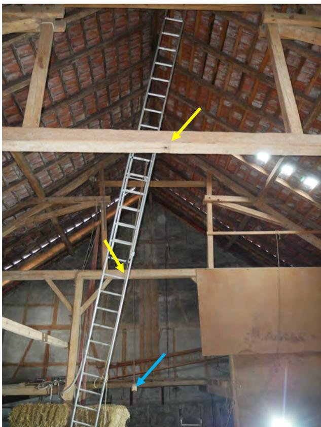
Die Stuhlkonstruktion im Querbund 2 und 3 scheint etwas improvisiert zu sein. Die Aufgesetzten Ständer zwischen Bundbalken und Stuhlstrebe wurde nachträglich eingebaut. Von Oben auf dem Bundbalken sind bei allen Ständern Schleifzapfenlöcher zu erkennen. Durch die obere und untere Zapfenverbindung kann der Ständer nachträglich ohne Schleifzapfenloch nicht mehr eingefahren werden.
