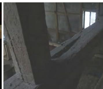
Abb. 27 Nut für Schleifzapfen
