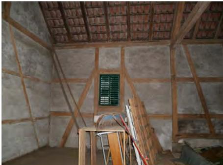
Abb. 8 QB4-QB3, Sprengwerk.
