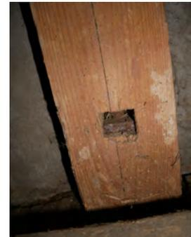
Abb. 10 Aufgehängter Torsturz balken an Fensterständer
