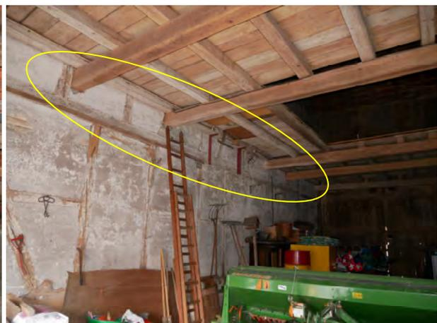
Abb. 14 Balkenlage Boden über Tenn ebenfalls auf den Ausfachungen aufgelegt
