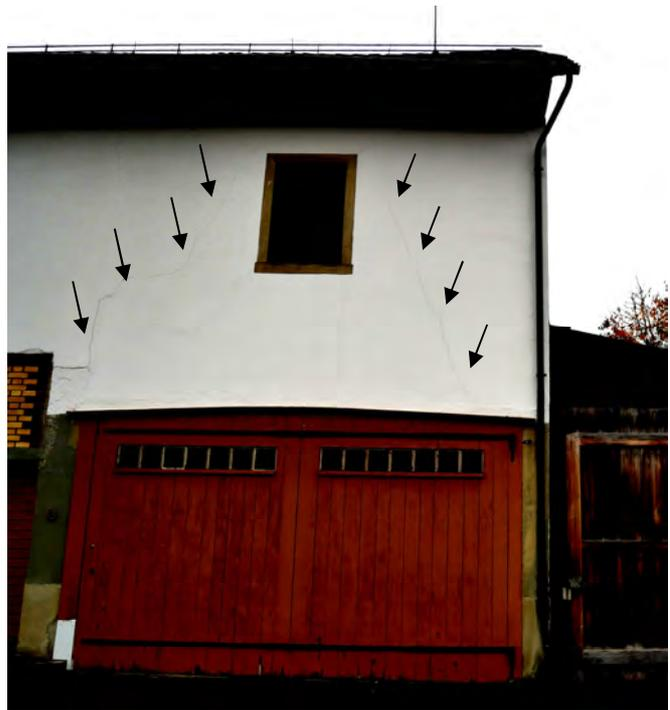
Abb. 40 Die Risse an der Vormauerung im Bereich des Kräfteverlaufes der Inneren Streben (Sprengwerk)
