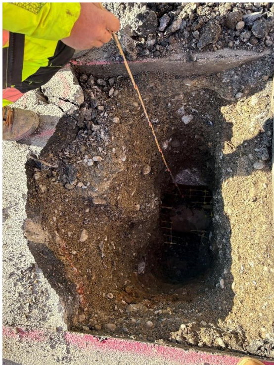
Abbildung 19: Sondage C Aufbau Bodenuntergrund (Quelle: INSTRAG Bauingenieure AG)
