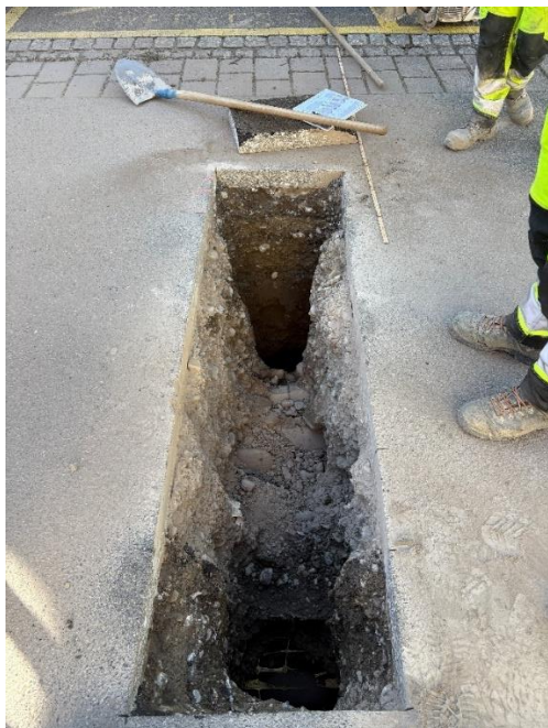
Abbildung 17: Sondage A Aufbau Bodenuntergrund (Quelle: INSTRAG Bauingenieure AG)
