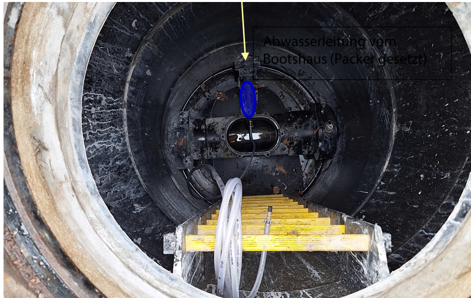
Foto 2: Packer in Abwasserleitung Bootshaus beim Anschluss an die Schmutzwasserkanalisation
