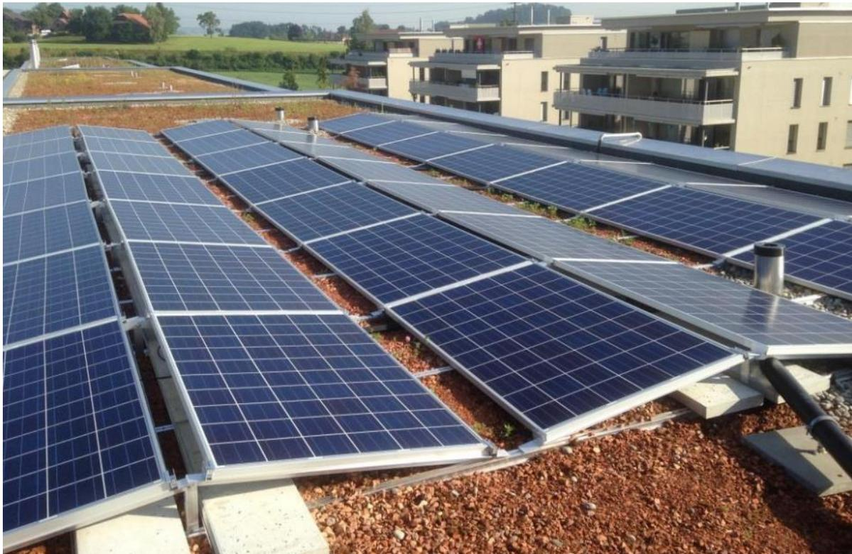
Abbildung 20, Beispiel einer Ost- West Aufgeständerten Anlage auf einem Flachdach (Quelle: Swissolar)
