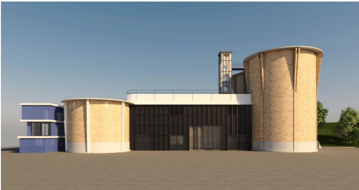
Abbildung: PV-Anlage integriert in die Südfassade des BG 1
