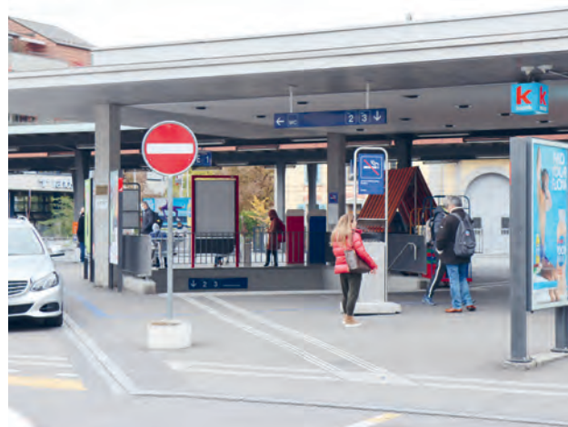
Abbildung 22: Personenunterführung Bahnhof Mitte.
