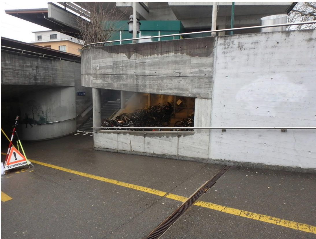
Abb. 19: U Stationsstrasse / Rampe Nord mit Velokeller (US05)
