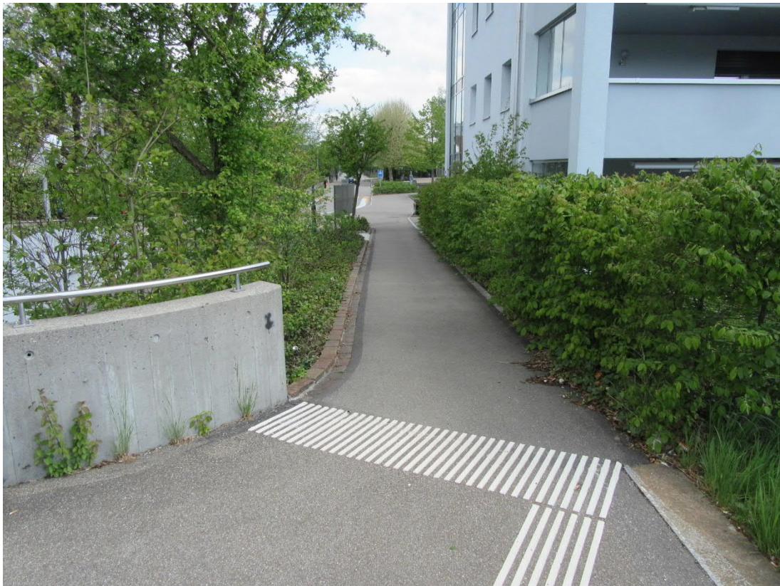
Abb. 1: Hausperron Gleis 1 / Zugang Süd (Stationsstrasse)
