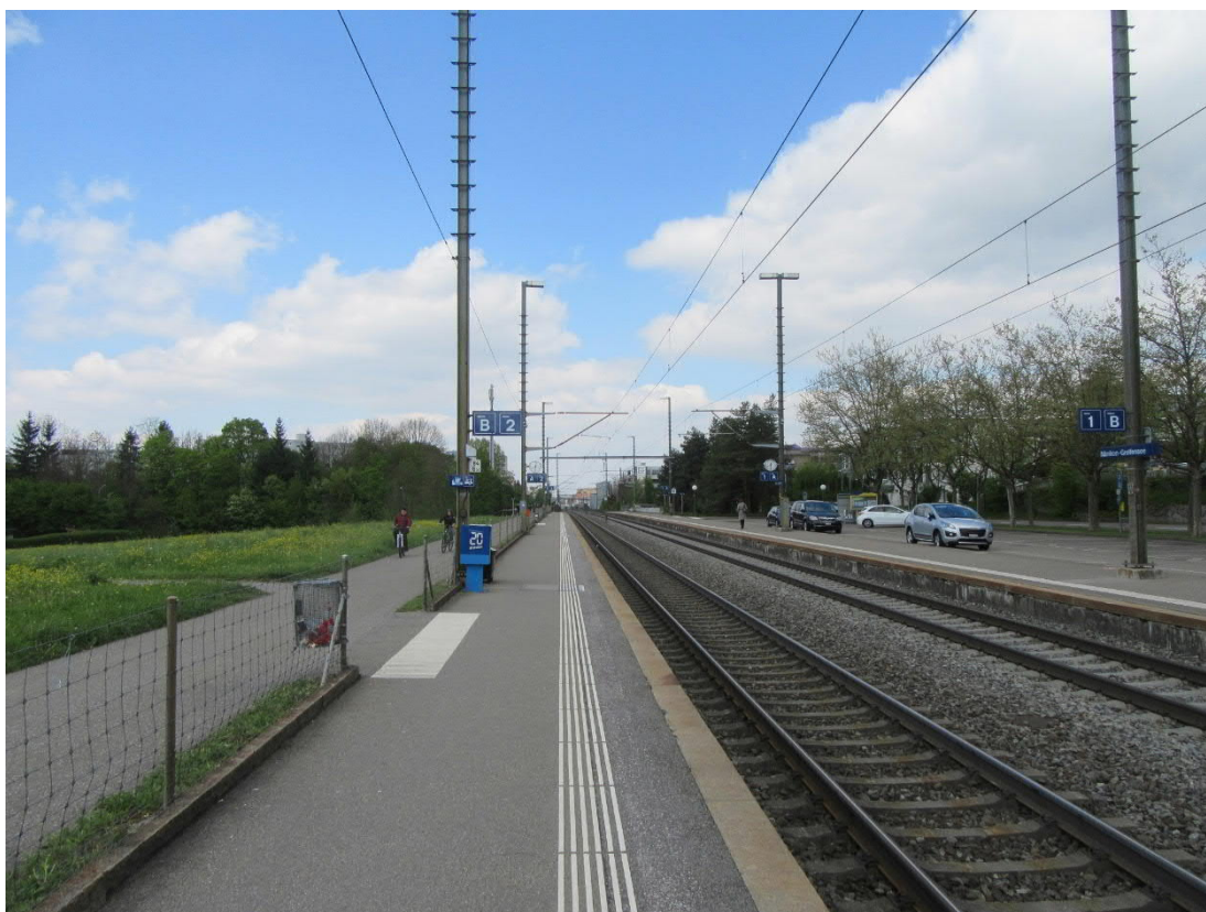
Abb. 14: Aussenperron Gleis 2 / Perronbereich Mitte (FI-Mast Nr. 87A), Blickrichtung Schwerzenbach
