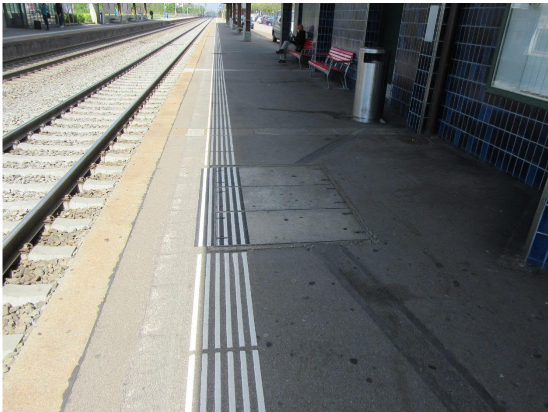
Abb. 3: Hausperron Gleis 1 / Perronbereich (AG01), Blickrichtung Schwerzenbach
