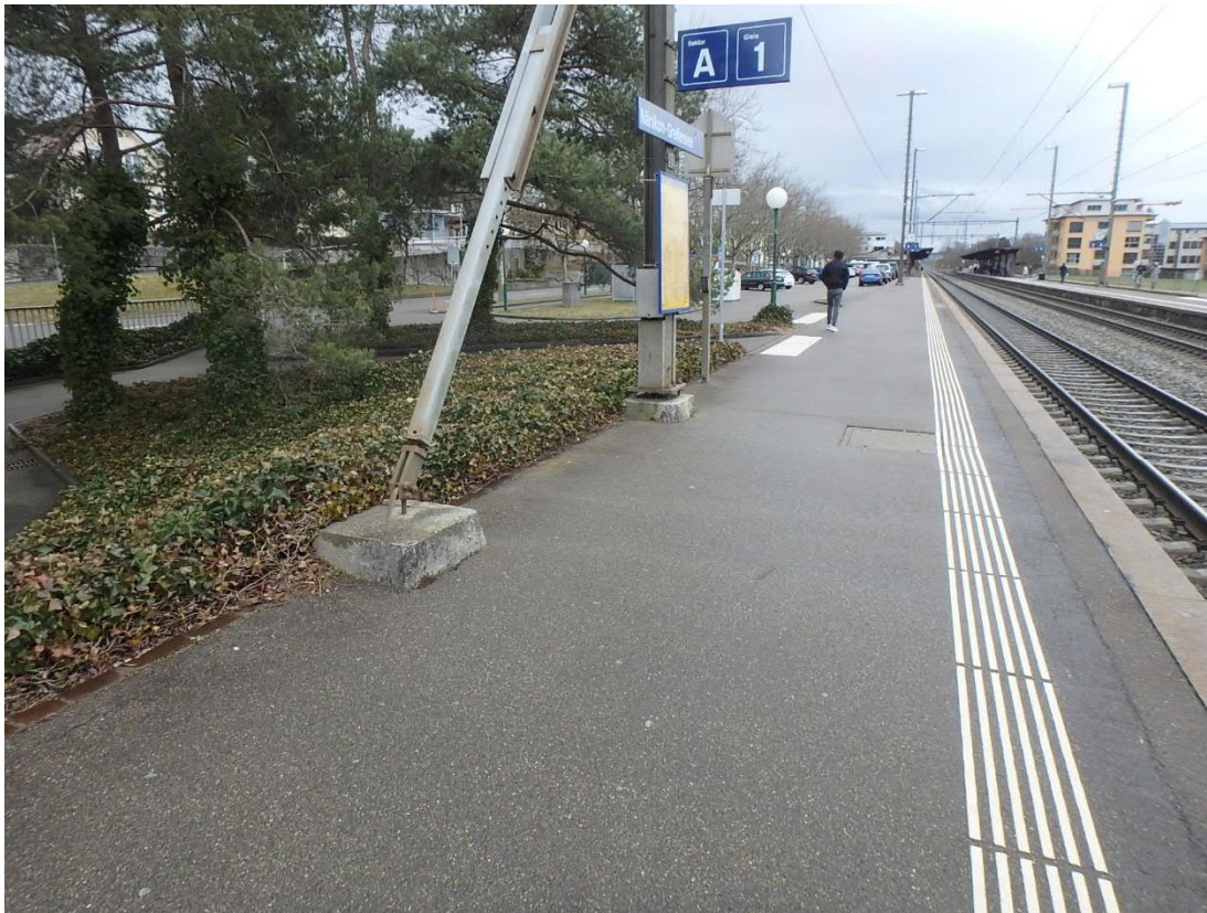
Abb. 7: Hausperron Gleis 1 / Perronbereich (FL-Mast Nr. 92), Blickrichtung Uster
