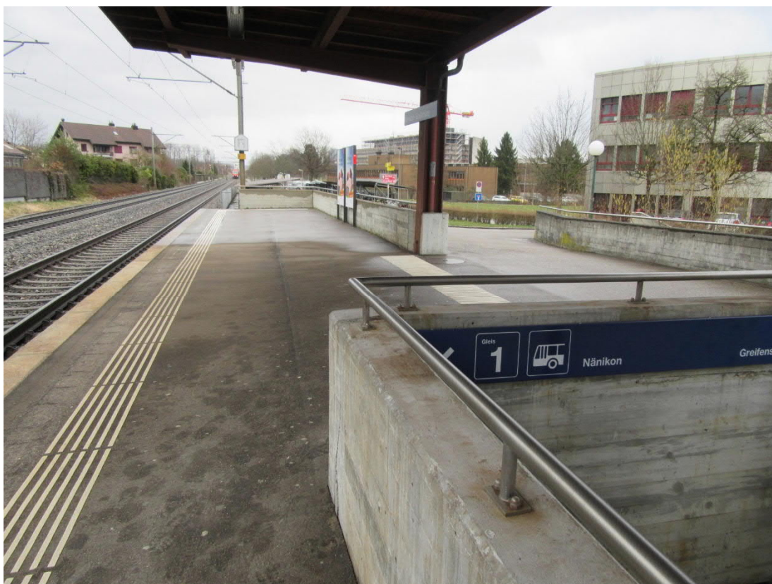
Abb. 10: Aussenperron Gleis 2 / Perronende und Zugang Süd (Stationsstrasse) Blickrichtung Uster
