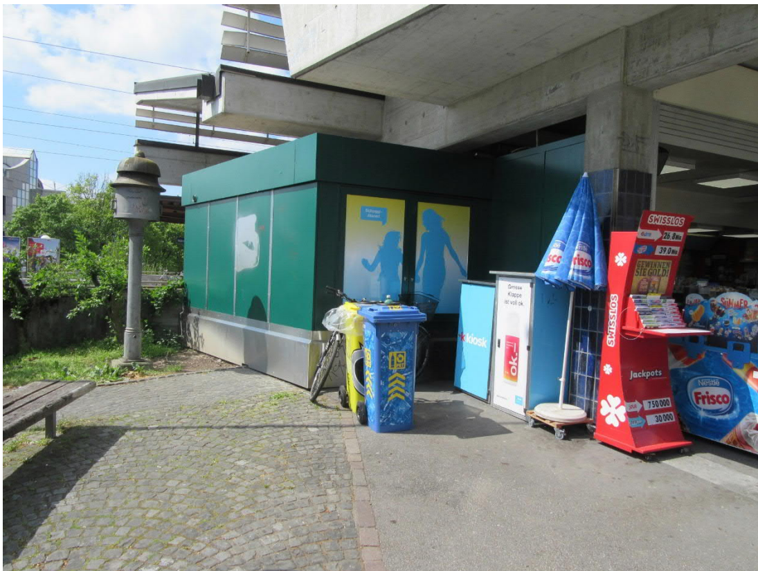
Abb. 22: Vorplatz / Kioskanbau (KI01) Blickrichtung Perron Gleis 1
