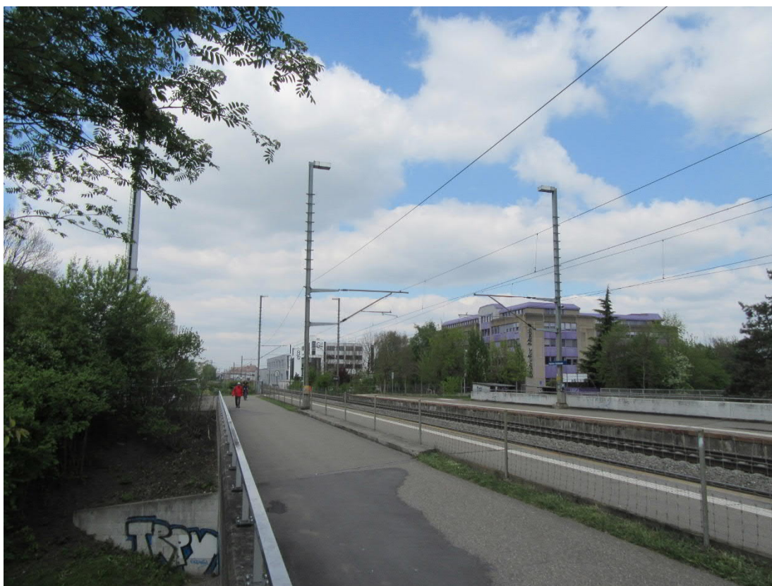
Abb. 15: Aussenperron Gleis 2 / U Verbindungsstrasse (FL-Mast Nr. 93), Blickrichtung Schwerzenbach
