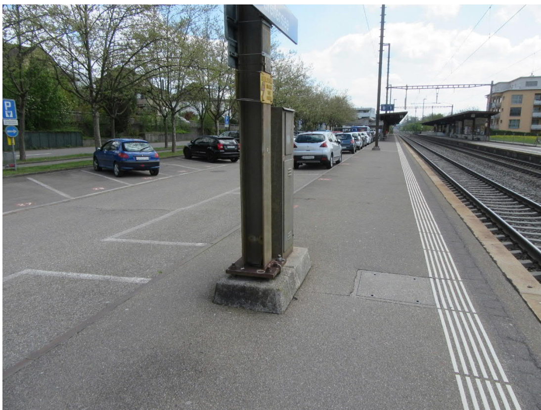
Abb. 5: Hausperron Gleis 1 / Perronbereich (FL-Mast Nr. 90), Blickrichtung Uster
