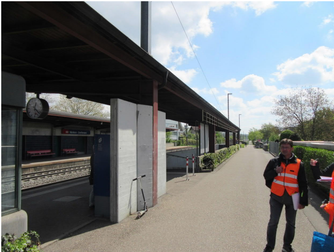
Abb. 11: Aussenperron Gleis 2 / Zugang Stationsweg Mitte (Rampenaufgang)
