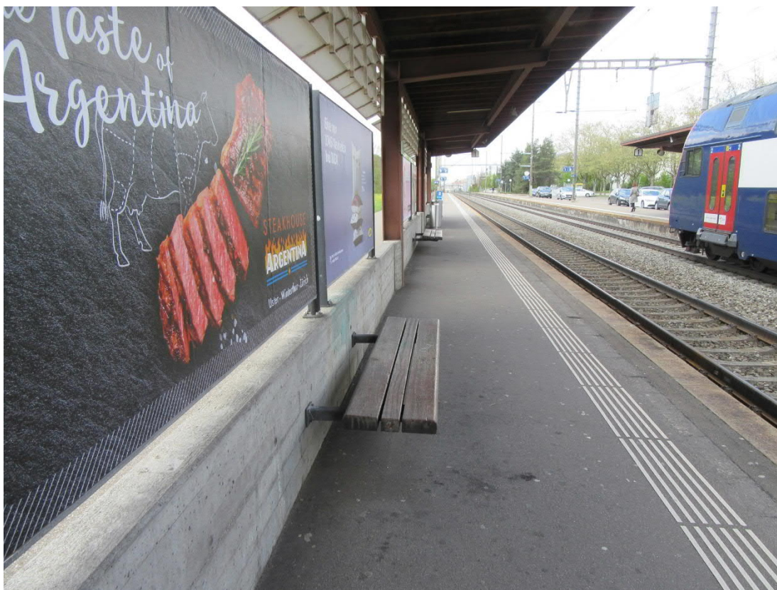
Abb. 13: Aussenperron Gleis 2 / Perronbereich (PD-02), Blickrichtung Schwerzenbach
