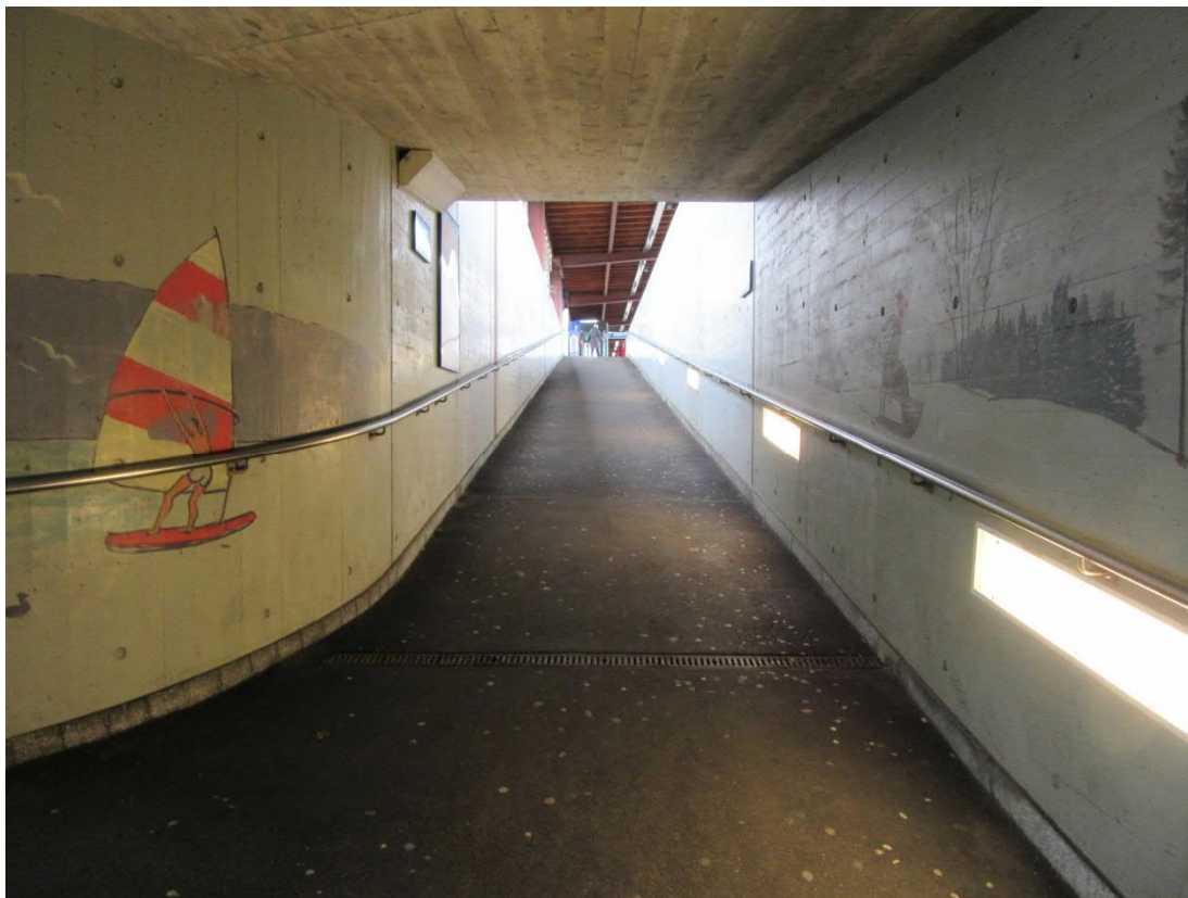
Abb. 17: U Stationsstrasse / Rampenaufgang zu Aussenperron Gleis 2
