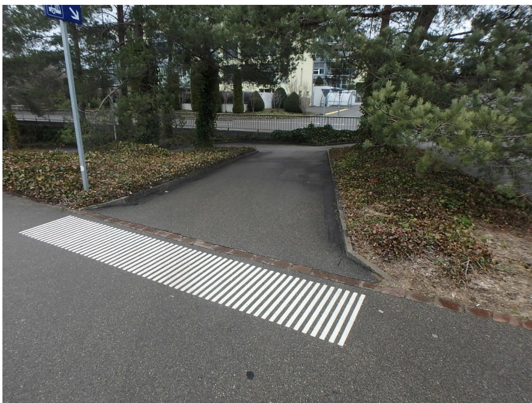
Abb. 6: Hausperron Gleis 1 / Zugang Nord (Schwerzenbachstrasse)
