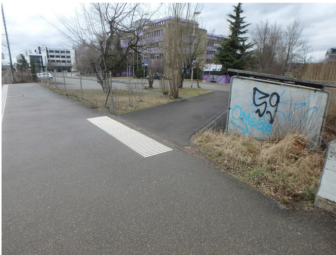
Abb. 9: Hausperron Gleis 1 / Perronzugang Nord (Grabenstrasse)
