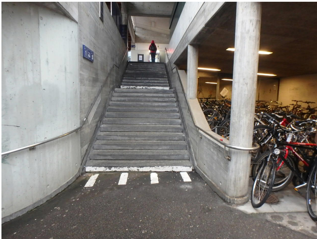
Abb. 18: U Stationsstrasse / Treppenaufgang zu Hausperron Gleis 1
