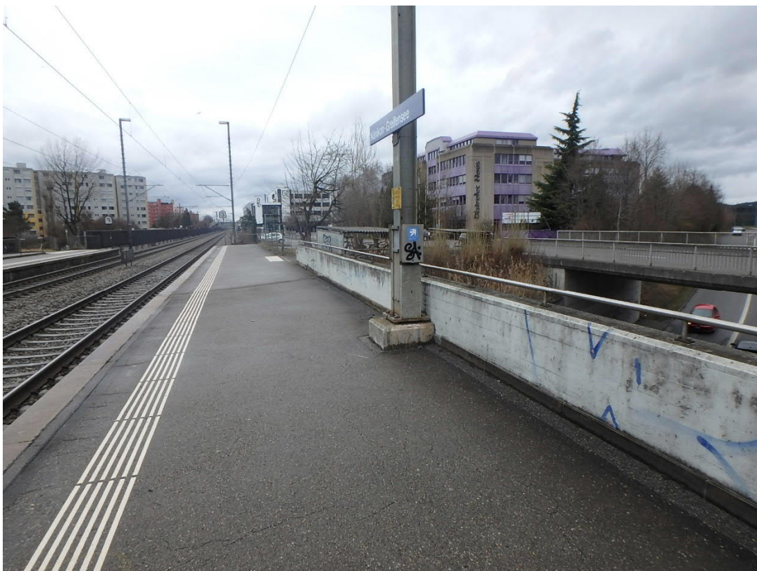
Abb. 8: Hausperron Gleis 1 / U Verbindungsstrasse (FL-Mast Nr. 94), Blickrichtung Schwerzenbach
