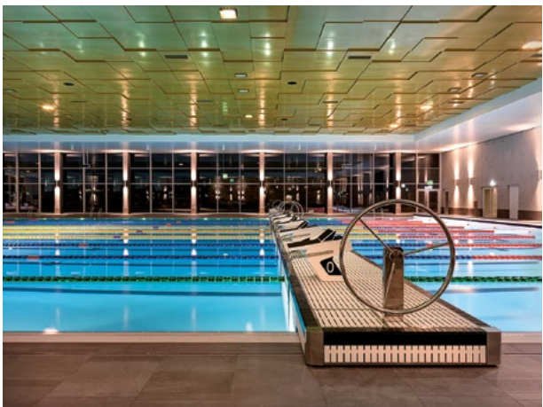
Verschiebbarer Trennbalken des 50-m-Olympiabeckens
