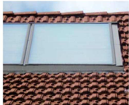
Abb. 18: Einheitliche Blechabschlüsse begünstigen die Integration
