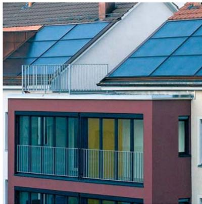
Abb. 15: Gute Lösung einer traufbündigen Solaranlage
