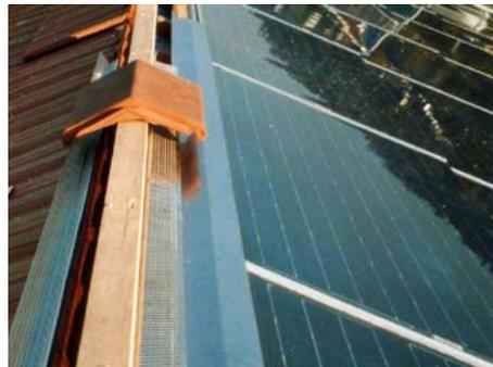
Abb. 14: Firstabschluss mit Ziegelsteinen
