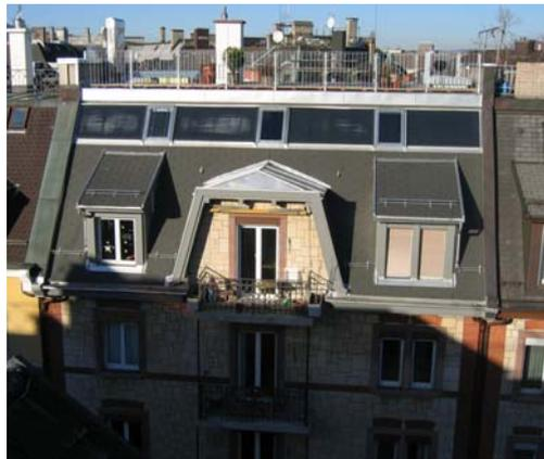
Abb. 21: Unauffällig in das Dach integrierte Solaranlage.
