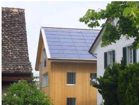
Abb. 13: Seitliche Dachränder bilden die Hauskontur
