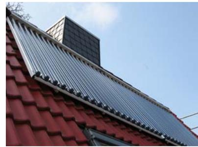
Abb. 2: Unverglaste Vakuumröhrenkollektoren höherer Ertrag im Winter
