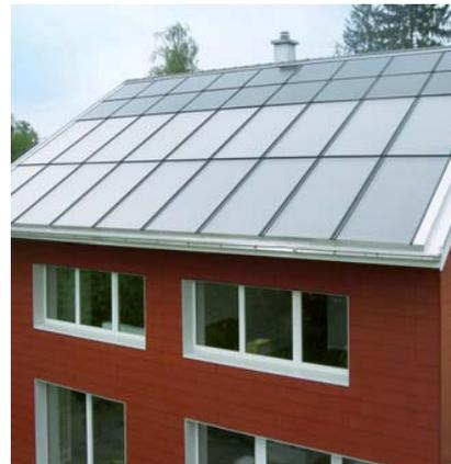
Abb. 22: Aufeinander abgestimmte Kollektorsysteme sorgen für eine gute optische Integration
