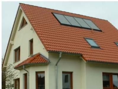
Abb. 1: Ins Dach integrierte Flachkollektoren entspricht dem üblichen Standard
