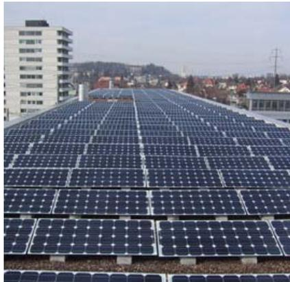
Abb. 23: Aufgeständerte Kollektorfelder laufen parallel zur Dachkante
