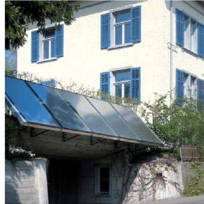
Abb. 20: Garagenvordach aus Sonnenkollektoren
