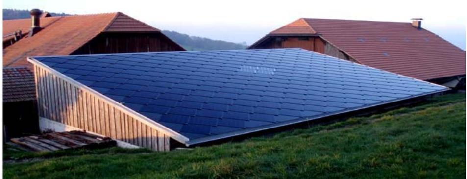
Abb. 8: Homogene Dachfläche mit Solarschindeln
