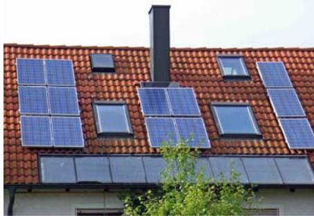
Abb. 11: Schlechtes Beispiel einer zerstückelten angeordneten Solaranlage
